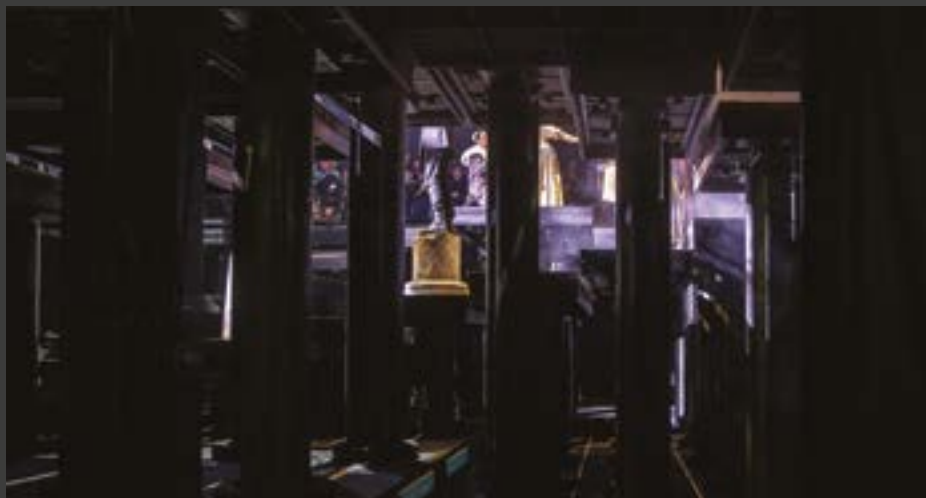
Az ember tragédiája (2018) előadás alulnézetből – a produkcióban a nagyszínpad mind a 84 süllyedője dolgozik, ezek mozgásával alakul és változik a játéktér
