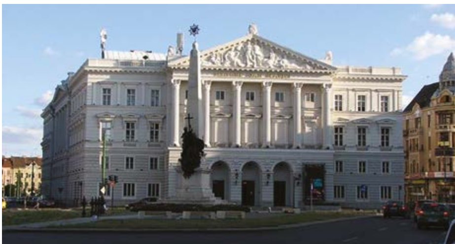
Az Aradi Nemzeti, ma Ioan Slavici Színház homlokzata, előtérben az 1901-ben felavatott és 2007-ben újra felállított Szentháromság szoborral (forrás: arq.ro)
