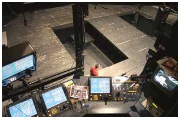
A színpadi emelőrendszer és a vezérlő 2004-ben (fotó: Eöri Szabó Zsolt, forrás: nemzetiszinhas.hu)
