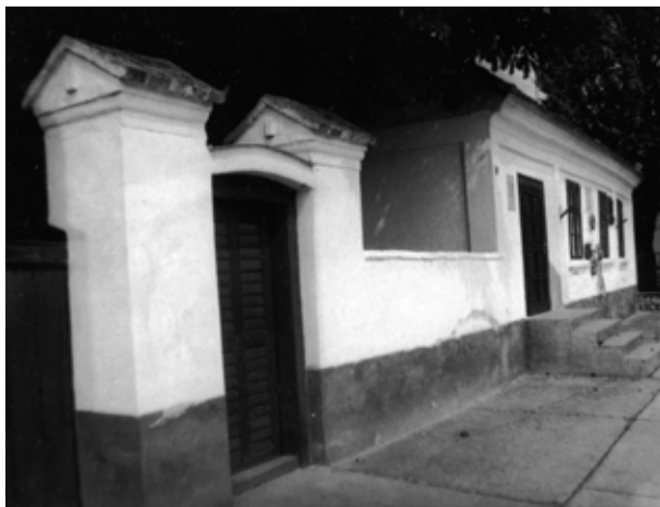
A volt jegyzői lak Sárszentlőrincen
