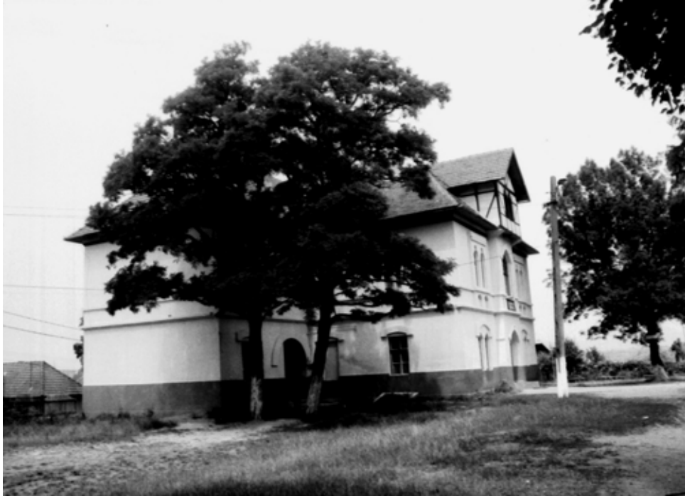
A koltói Teleki-kastély
