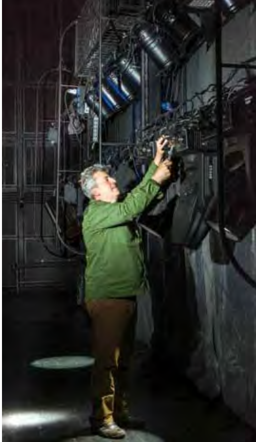
Világítási híd robotlámpákkal. Színek, vetített formák, irányok és teljesítmény – ezeknek a lámpáknak minden tulajdonsága távvezérelhető és programozható.
